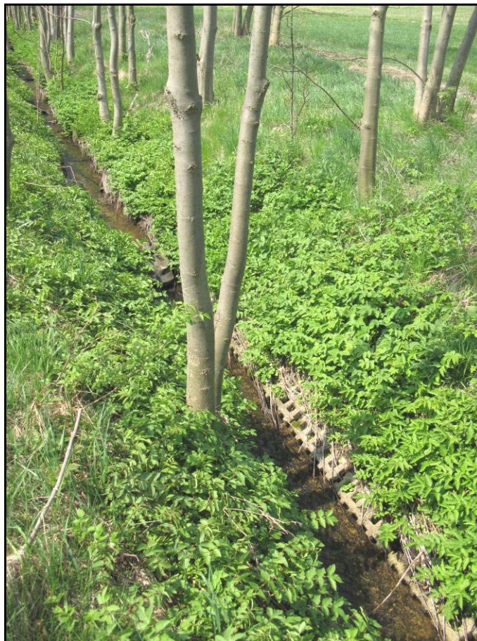
Abb. 3: begradigter und mit Gittersteinen ausgebauter Bachabschnitt im Wassergrund (Seiffhennersdorfer Südflur)
